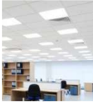
Dalles avec éclairage LED
