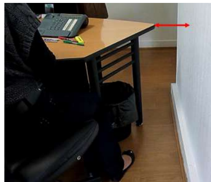
Espaces de circulation et de dégagements insuffisants
